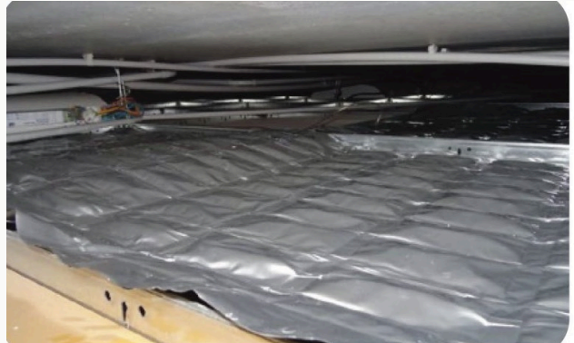
Posa nell'intercapedine, sopra le piastrelle esistenti: nessuna opera, nessun cantiere.
